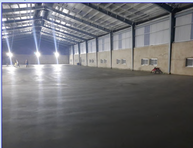
➤ Nhà kho sản xuất, dự án Spa Nho/ Production warehouse
