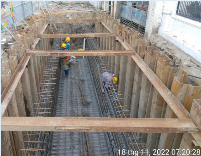
➤ Nâng cấp kênh Tân Tài Upgrade Tan Tai Canal
